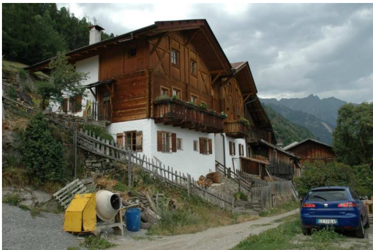
Abb3 Ansicht von Westen
